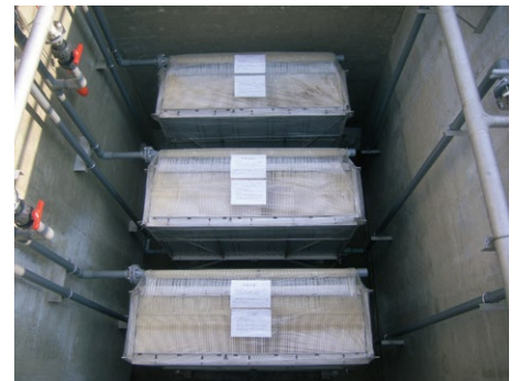
液中膜据付状況
