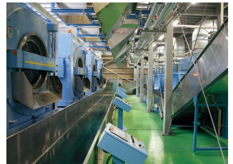
処理水の再利用先（洗濯工程用水）
